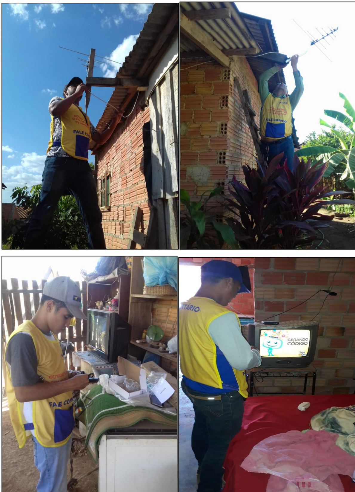
Figura 20. Instalação de Antena.
