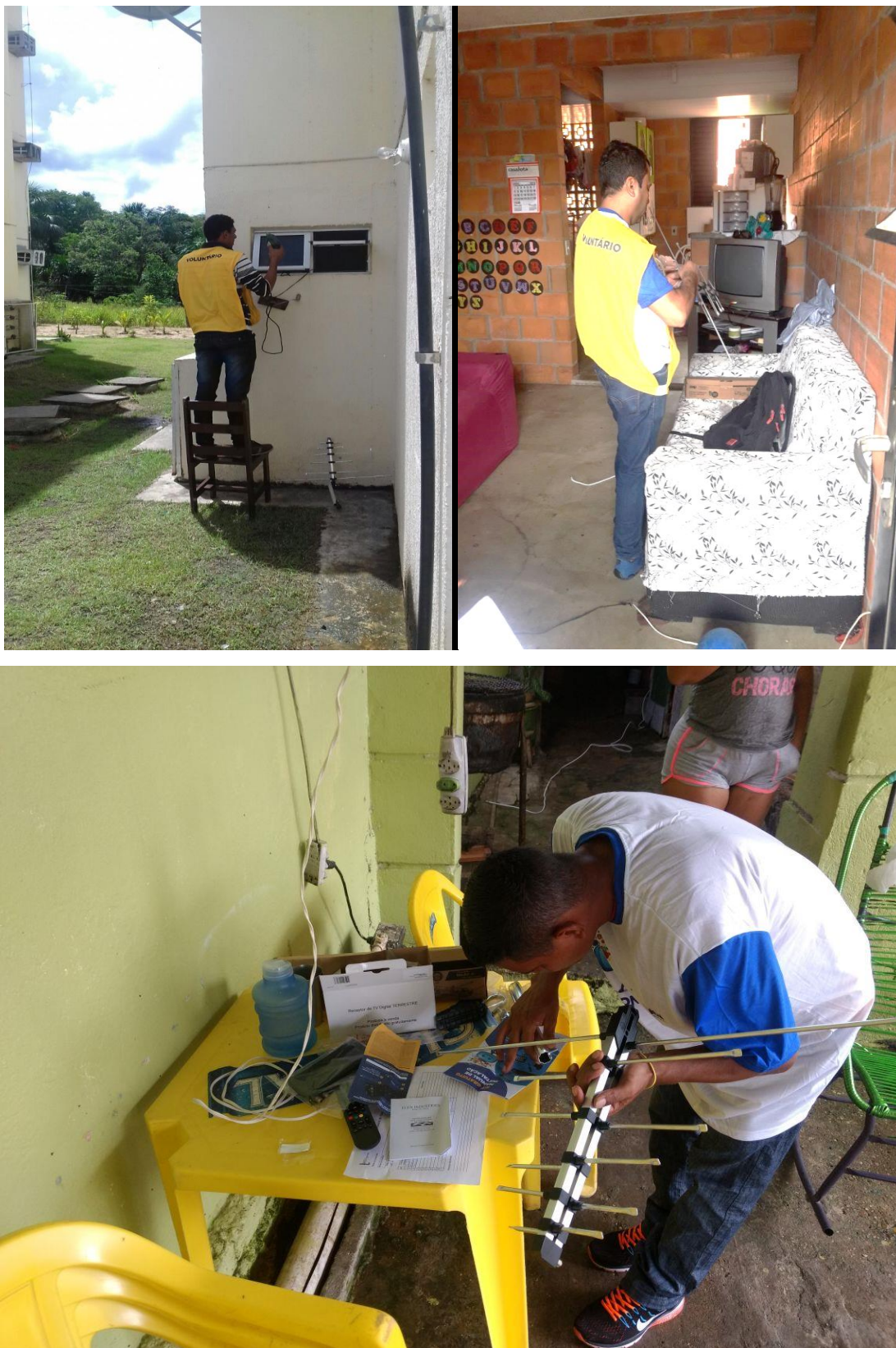
Figura 43. Instalação de Antena da TV Digital.
