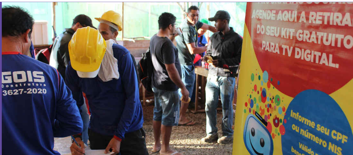
Canteiro de obras da Construtora Gois, em Valparaíso de Goiás
