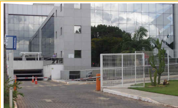
BANCO DO BRASIL Edifício Sede VI- SIA Trecho 2, Lt. 1512
